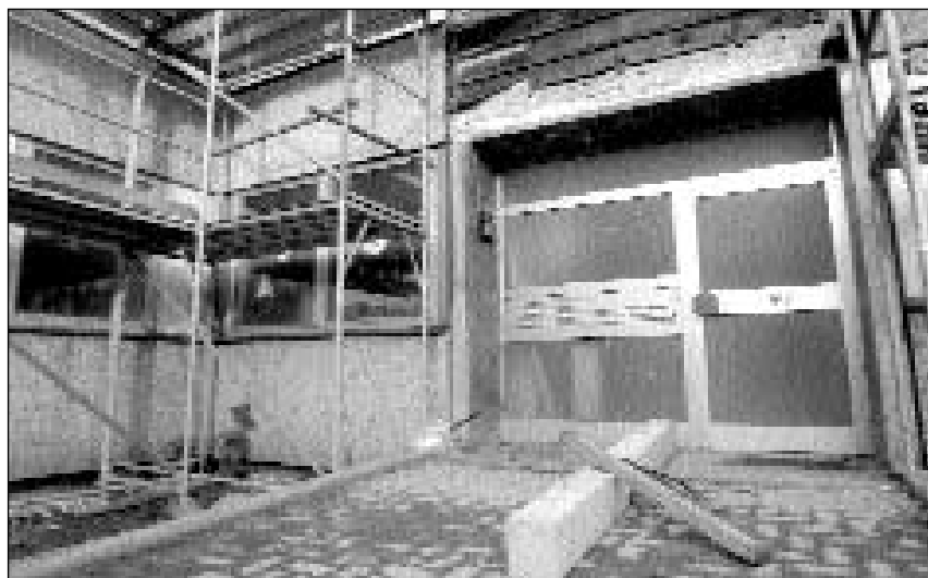
Das Wohnheim an der Ostenbergstraße ist eine Baustelle.
